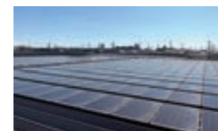
太陽光発電設備
