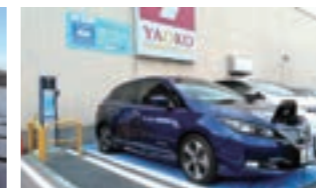
EVステーション
