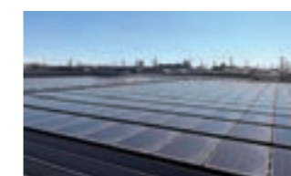
太陽光発電設備
